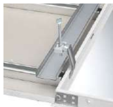
①ハンガーを外枠にセットします。
